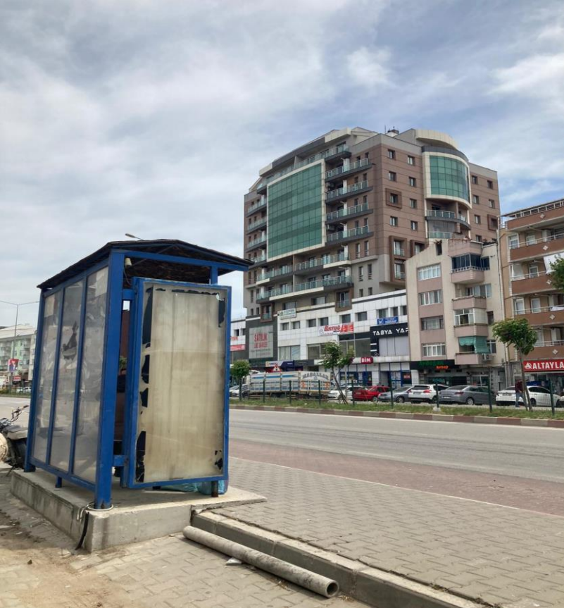
Resim4: Bölgenin en yüksek yapısı (11 katlı)
