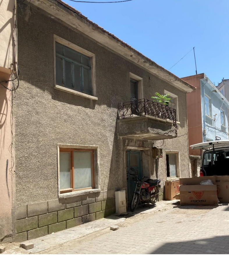
Resim7: Orta durumda olan bir yapı örneđi
