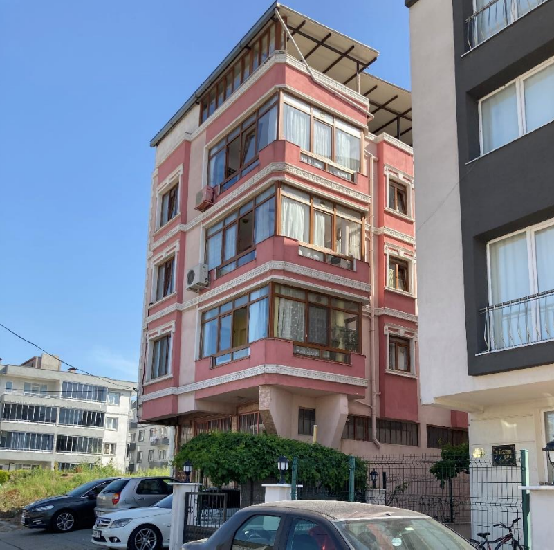
Resim3: Sahil bölgesinde bulunan 4 katlı bir yapı
